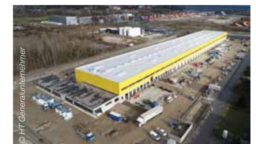
... nur zwei Monate später ist die Logistikhalle mit einer Nutzfläche von ca. 12.000 m 2 errichtet.
