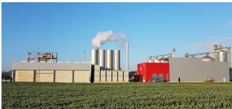
Die neue Ölpressen der VFI ist ein weiterer Meilenstein in der Entwicklung des ecoplus Wirtschaftsparks Ennsdorf. © VFI
